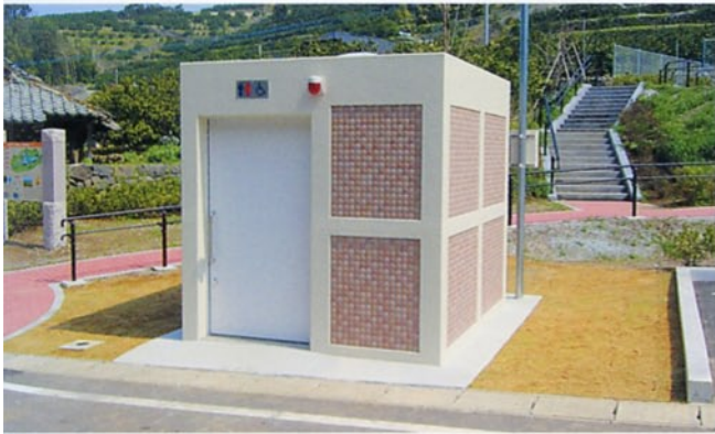
1棟タイプ 【多目的:大1】 タイル貼り
